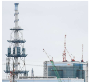
工事が進められている東海第二発電所
