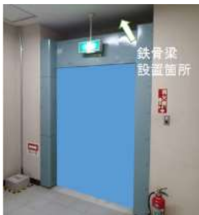
鉄骨梁補強箇所の状況 (浸水防止扉)
