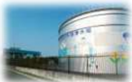
東海村外宿浄水場
